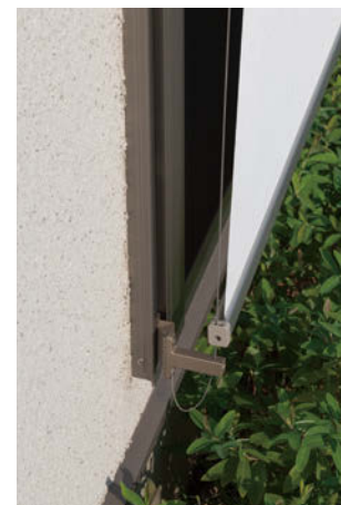
サッシ取付け時 下部アップ
